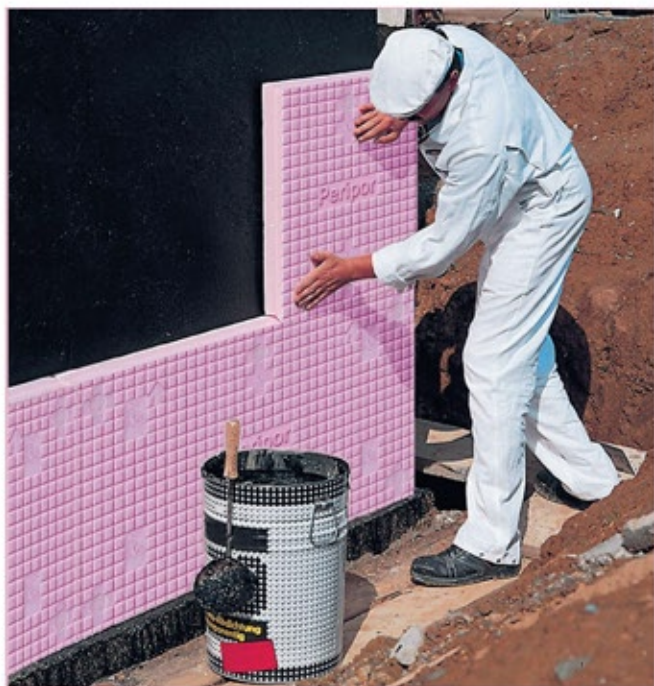
Εικ. 2 Μόνωση περιμετρικών υπόγειων τοιχείων
