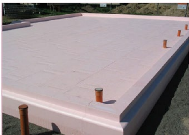
Εικ. 3 Μόνωση θεμελίων
